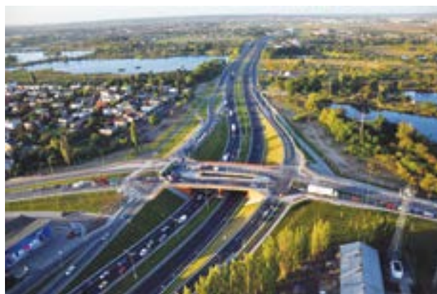
Przebudowana do rangi drogi ekspresowej ulica Głogowska.
