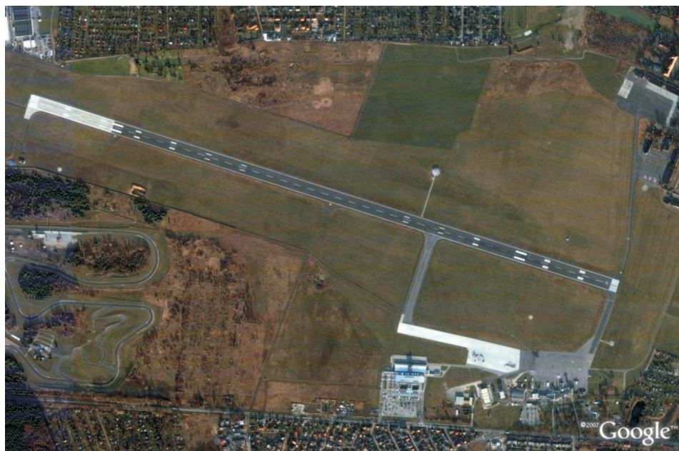
Ryc. 3.1. Zdjęcie satelitarne Portu Lotniczego Poznań-Ławica Źródło: Zdjęcie satelitarne z programu Google Earth.
