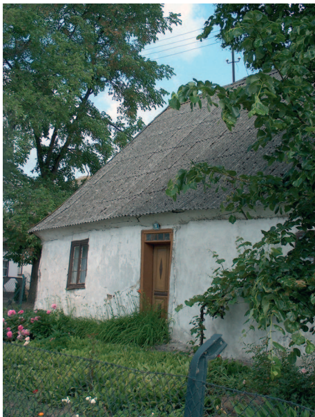
A. Dom mieszkalny wzniesiony w konstrukcji drewnianej i otynkowany
