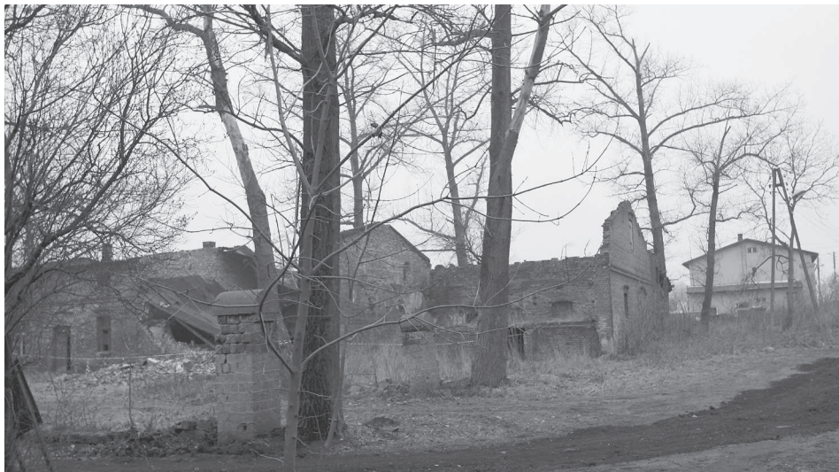
E. Pozostałości zabudowy folwarcznej w Latalicach
