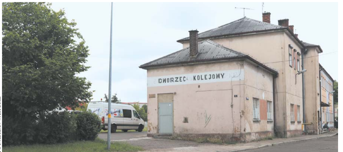
Tak dzisiaj wygląda budynek dworca w Śremie
